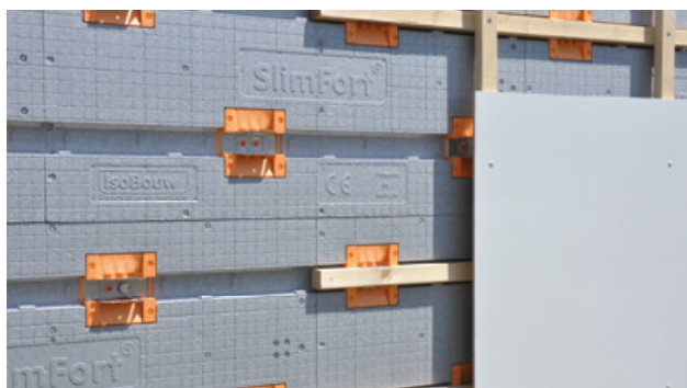
Afwerking met vezelcementplaten
