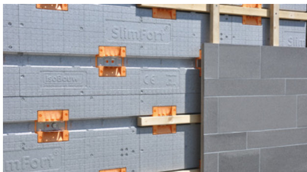
Afwerking met tegels
