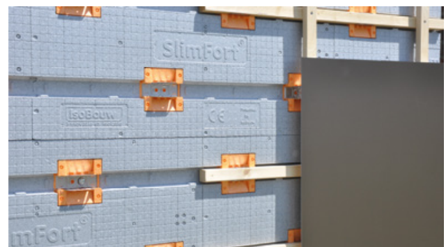
Afwerking met aluminium composietplaten
