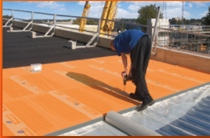
plat dak isolatie
