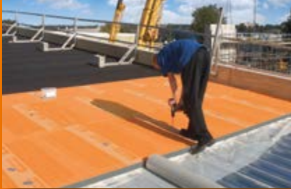
plat dak isolatie
