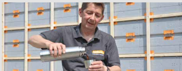
In recordtempo gereed voor de gevelbekleding
