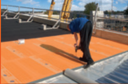
plat dak isolatie
