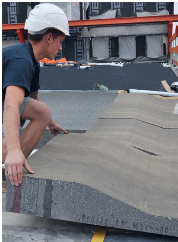
\* Pour les toits non isolés, nous recommandons une épaisseur initiale d'au moins 40 mm conform EN 13163.
