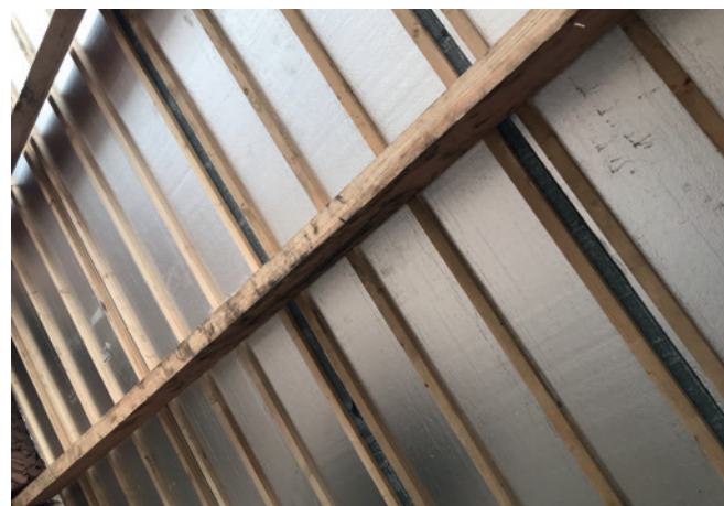
Côté intérieur : Simplicité de pose des canalisations et liberté de choix pour la finition intérieure
