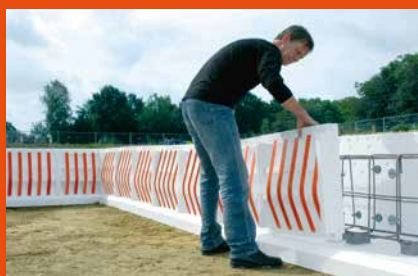
coffrages de fondation
