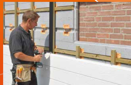
isolation de façade
