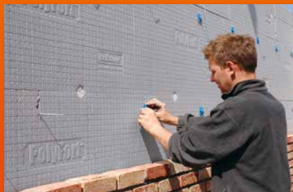
isolation des murs
