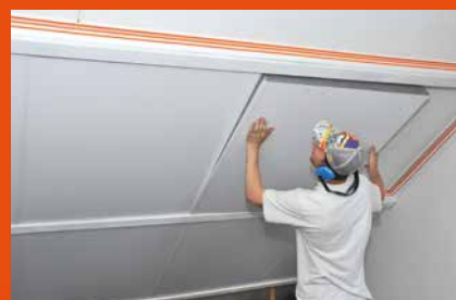
isolation de plafond
