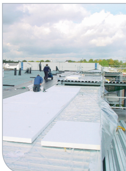
♣ Application d'isolation des toitures plates
