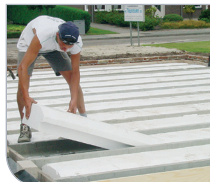
↑ Application d'isolation du sol au moyen d'éléments façonnés
