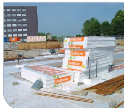
↑ Application d'isolation du sol au moyen de panneaux
