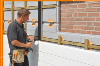
Isolation des murs creux
