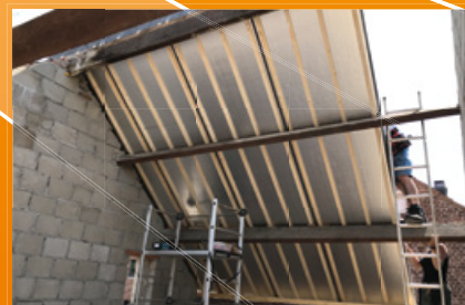
isolation de toiture inclinée
