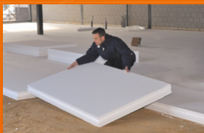
Isolation de sol
